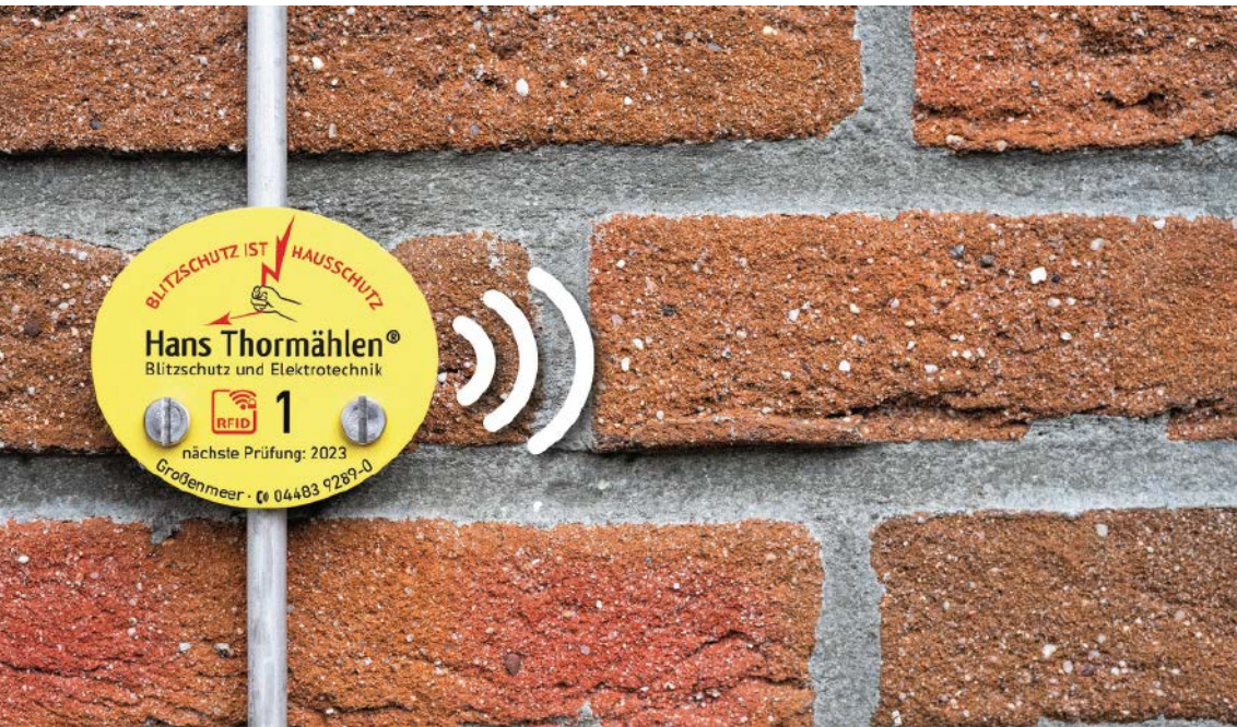
Smarter Blitzschutz: Zur Installation und Wartung der Anlagen nutzt die Hans Thormählen GmbH & Co. KG markierte Plaketten mit RFID-Chip
