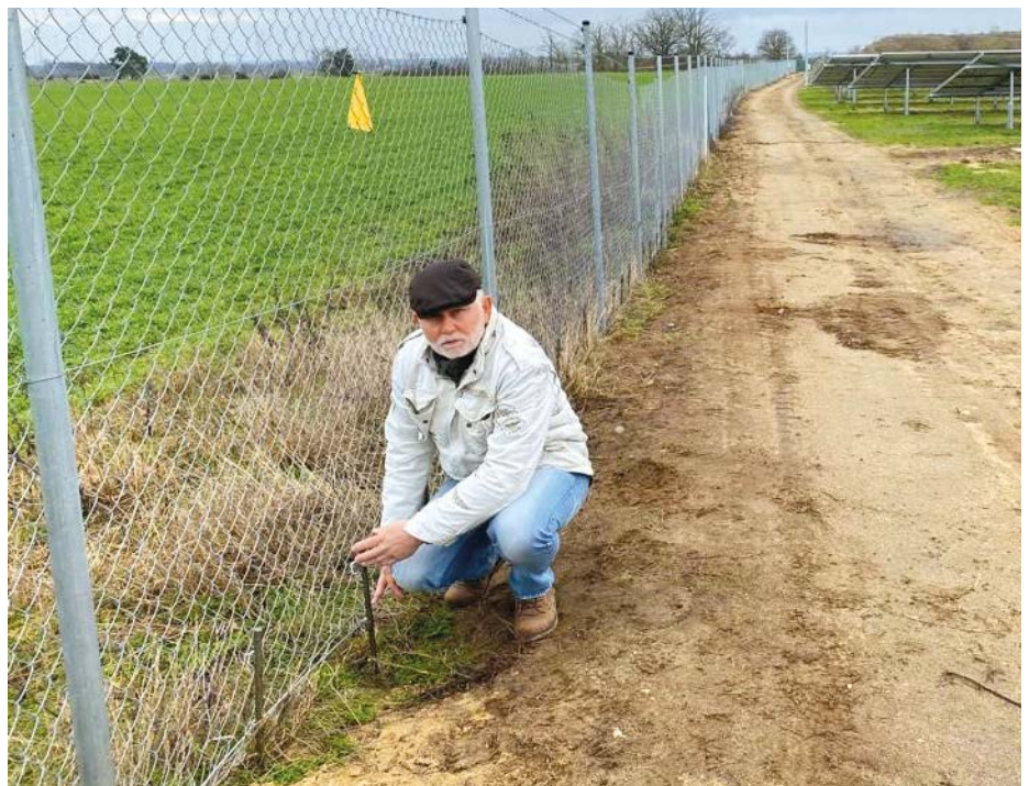
Roland Popp, Avasun inspiziert die Ertüchtigung des mechanischen Zaunsystems, das jetzt auch Wildschweinen standhält
