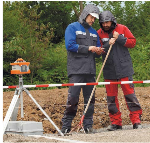
Gute Pflege sichert langfristigen Wetterschutz
