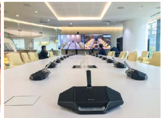
Nahtlose Integration der Dientis-Lösung in die Gebäudetechnik
