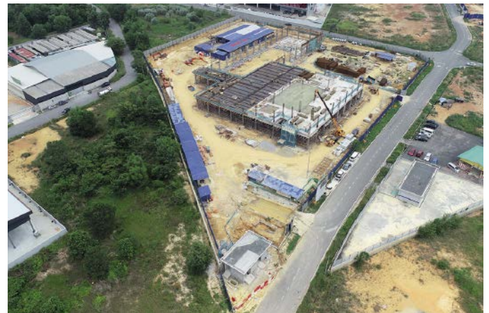
Bau eines Leuze-Produktionsstandorts in Malaysia
