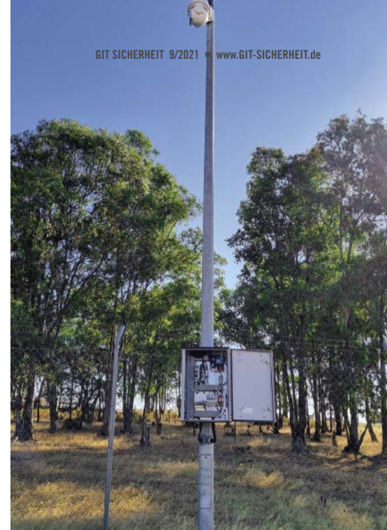
▲ Solarpark-Perimetersicherungslösung mit durch Slat DC-USV-gepufferter Videoüberwachung
