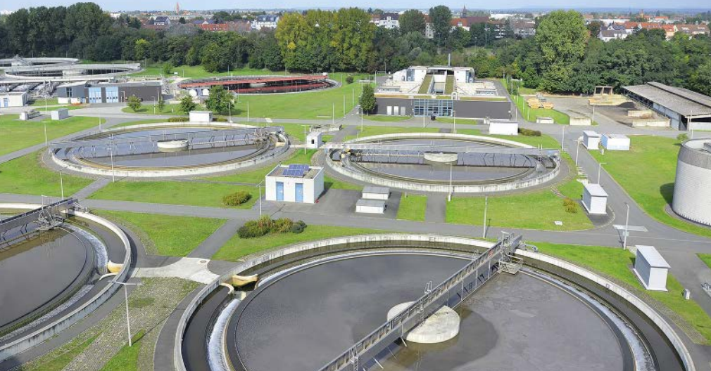
Außenaufnahme: Blick über das Klärwerk
