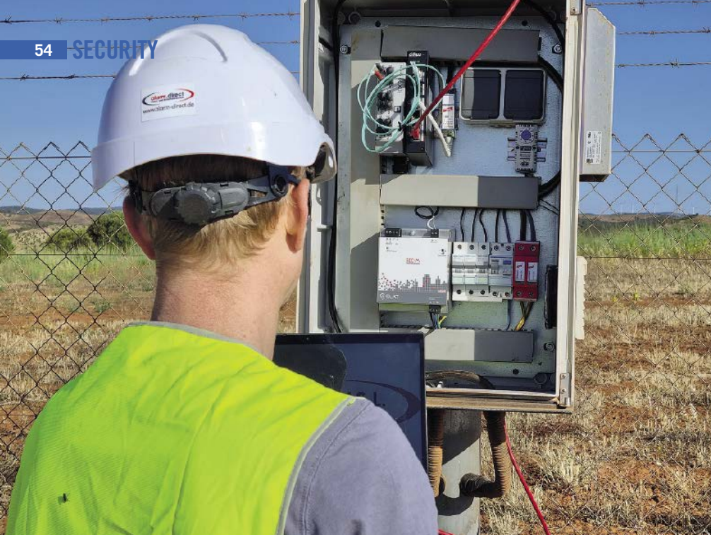
▲ Slat Mikro-USV vom Typ SDC-M 48V DIN2 RS sichert den zuverlässigen Weiterbetrieb der angeschlossenen Geräte bei Netzausfällen und Mikrounterbrechungen
