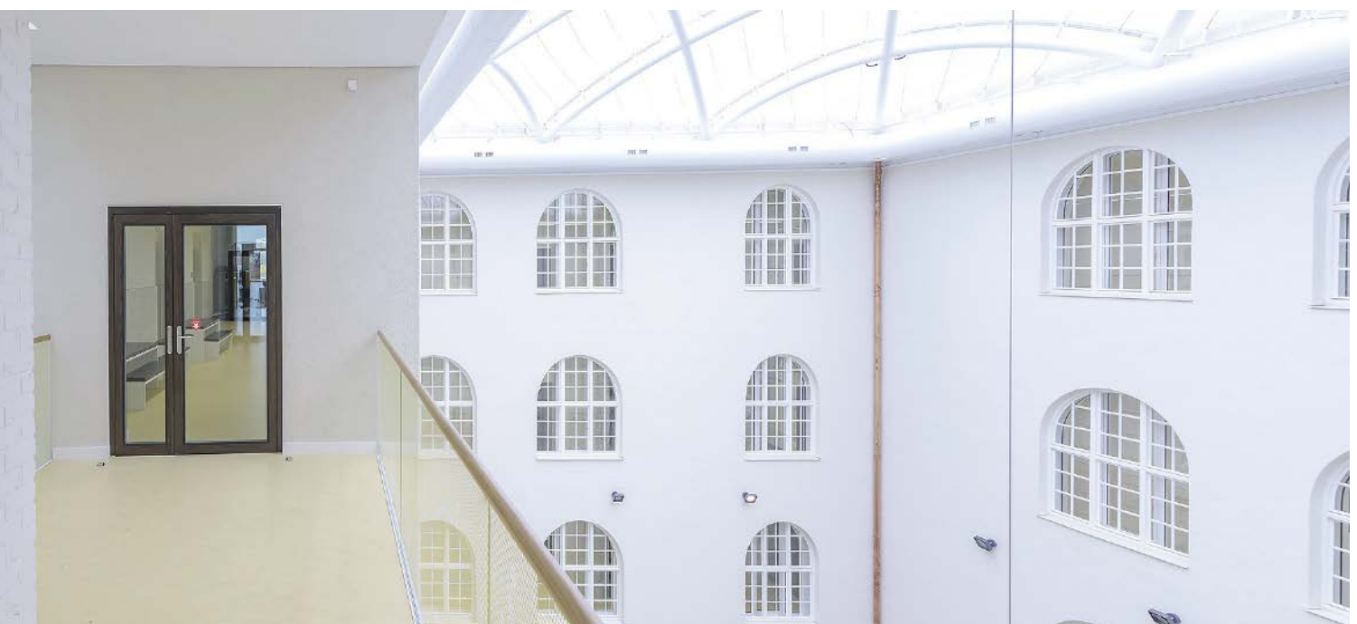
Das Architekturbüro Karl + P aus München sanierte und erweiterte die Grundschule: zu den Umbaumaßnahmen gehörte, dass die Schule in unterschiedliche Brandabschnitte unterteilt werden musste
