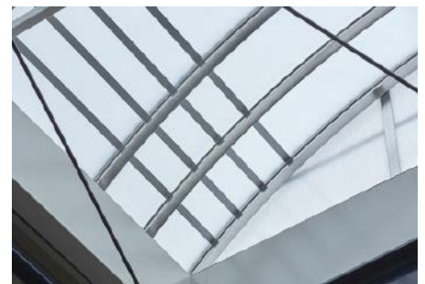
Für Lichtkuppeln und Lichtbänder sind eine Vielzahl von Lösungen zur Durchsturz sicherheit auch für die Nachrüstung verfügbar
