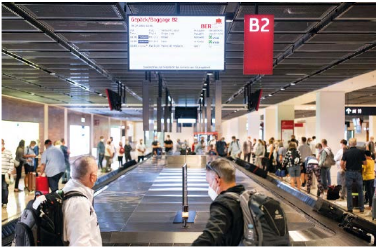
BER Flughafen Gepäckausgabe Geräteintegrierter Brandschutz
