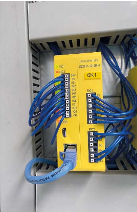
Die Produktreihe SCR DI besteht aus einer Kombination aus Sicherheitsrelais und Diagnosemodul und vereint die Funktionen eines klassischen Not-Halt- oder Schutztürwächters mit denen eines SRF Di Diagnosegerätes, nämlich der Übertragung der DCD Daten mittels IO-Link, NFC und USB
