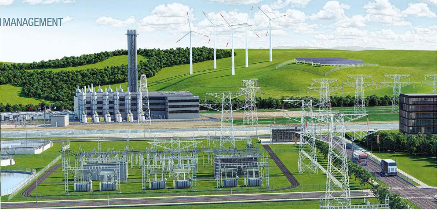
Manipulation oder Sabotage von schwächer gesicherten, peripheren Elementen wie Umspannwerken können Einstiegspunkte für Cyberangriffe sein
