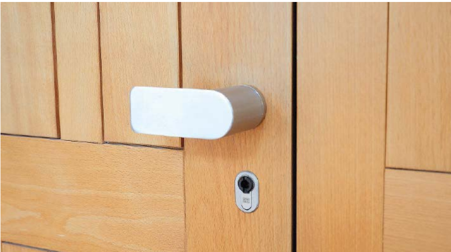
Für den Austausch der mechanischen Türzylinder waren keine Umbauarbeiten an den Türen erforderlich, denn die elektronischen Zylinder haben dieselben Abmessungen
