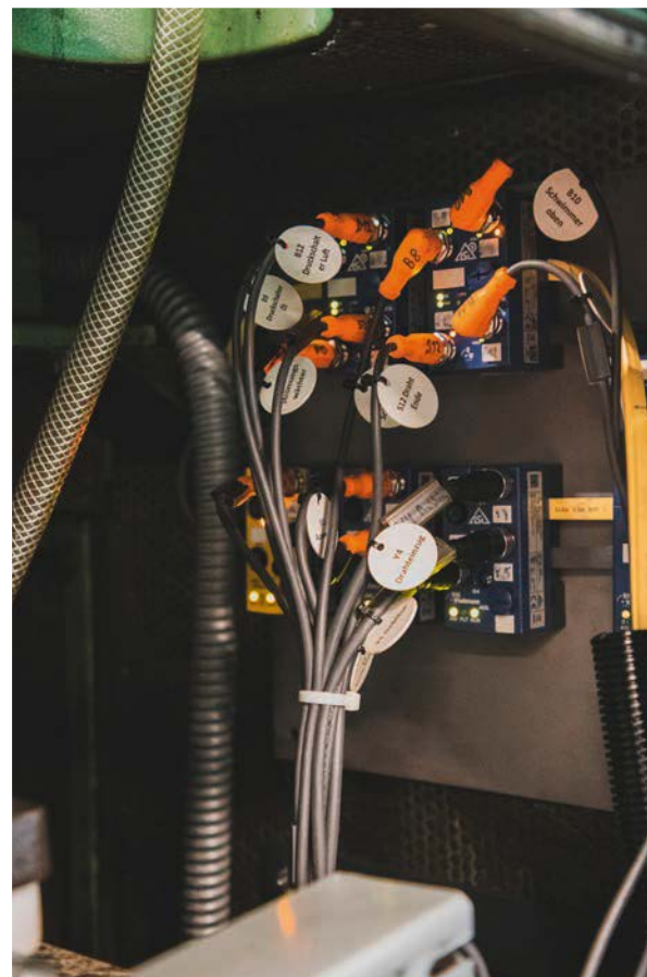
Die Einbindung von IO-Link Sensoren erfolgt über die ASI-5 Module mit integriertem IO-Link Master mit vier Master Ports von Bihl+Wiedemann.
