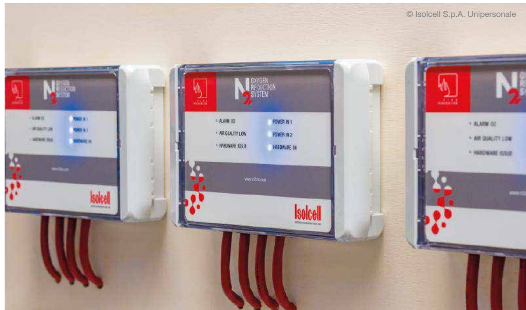
Die verschleißfreien, hocheffizienten optischen Sensoren erfassen die Sauerstoffkonzentration im Schutzbereich punktgenau
