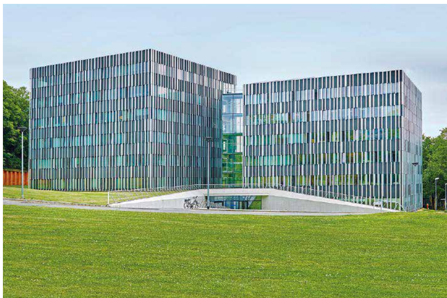
Die RWTH Aachen setzt beim ICT Cubes Gebäudekomplex der Universität auf ein ganzheitliches Sicherheitskonzept rund um die Tür
