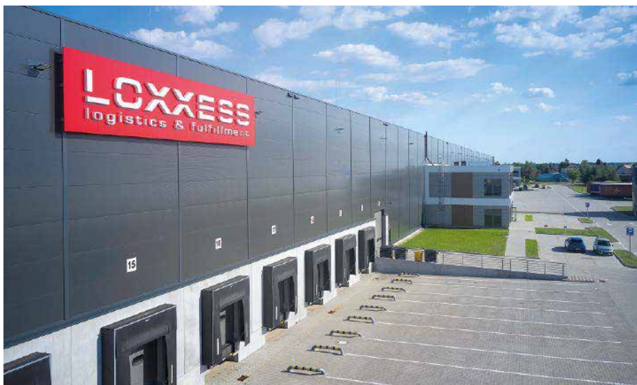
Loxxess betreibt ab Ende 2022 im tschechischen Bor eine neue Logistikhalle mit 68.000 m 2 Fläche
