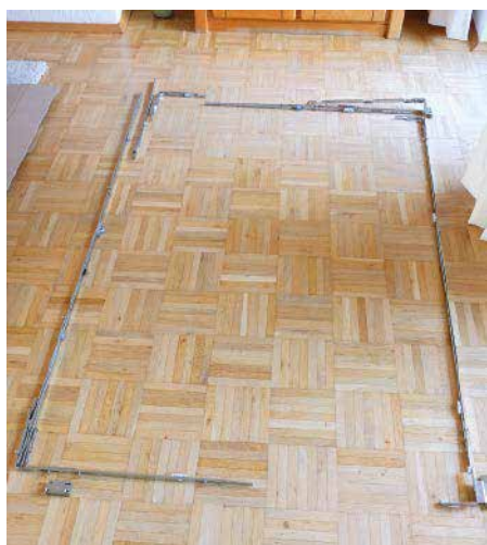
Der neue BKS Protect-Beschlag vor der Montage an der ersten Terrassentür
