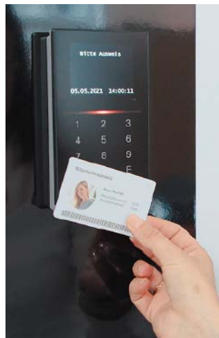
Zwei-Faktor-Authentifizierung für den Zutritt zu hochsicherheitssensiblen Bereichen, wie etwa Serverräumen oder Technikräumen
