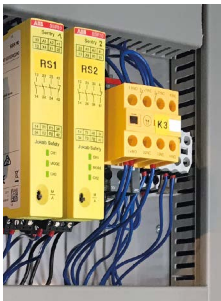
ABB-Sicherheitsrelais des Typs Sentry SSR10 überwachen, ob alle Glastüren geschlossen sind, damit niemand durch bewegliche Maschinen verletzt werden kann
