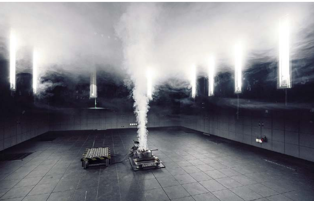
Hekatrons „Elba“ (Erprobungslabor für Brandmelder-Applikationen) ist eines der modernsten Brandlabore der Welt: Auf 280 qm Fläche können Prüf- und Testbrände weit über die geltenden Normen (z. B. DIN EN 54) hinaus durchgeführt werden
