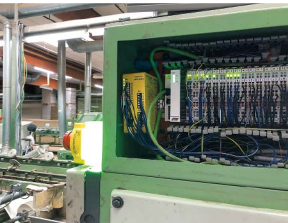
▲ Retrofit einer Kaschieranlage aus dem Jahre 1996: Unter anderem kommen darin nun Seilzugschalter und beleuchteten Not-Halt Geräte von Bernstein in einer elektronischen Sicherheitskette zum Einsatz
