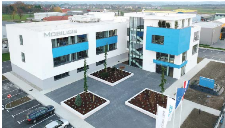
Das Gebäude des Mobilisis Firmensitzes in Varaždin/Kroatien
