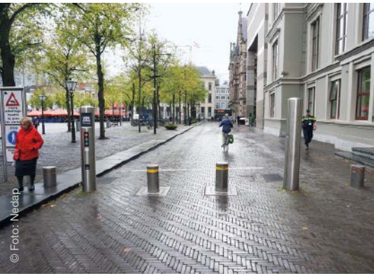
Zufahrtssteuerung von Nedap für den Einsatz in Städten
