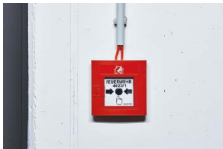
▲ Um Täuschungsalarme sicher auszuschließen, sollten geeignete Brandmelder, wie punktförmige Brandmelder oder Handfeuermelder, zu installieren und parametrieren.
