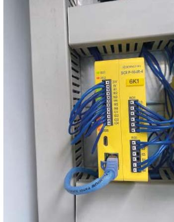
Die Auswertung SCR P minimiert den Verdrahtungsaufwand und spart durch die Kombination mehrerer Sicherheitsrelais in einem Gerät deutlich Platz im Schaltschrank
