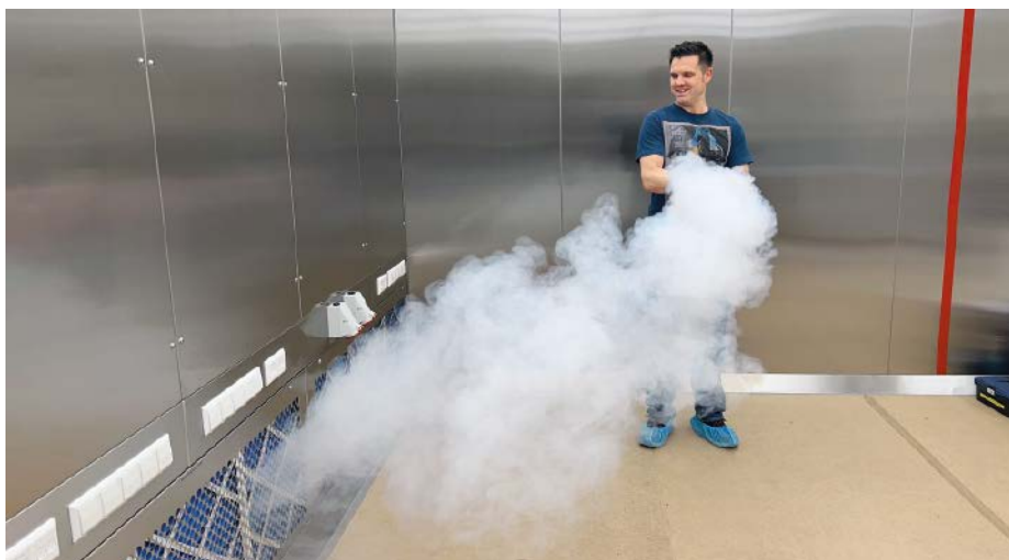
Luftgetragene Partikel werden effektiv erfasst, indem sie zu Boden gedrückt und abgesaugt werden
