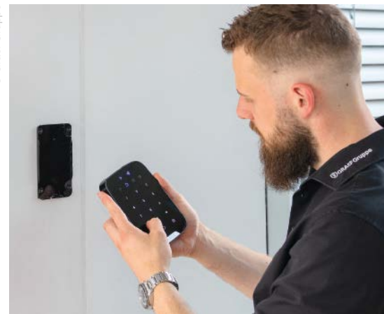
Lukas Olfert, Graef Distribution, bei der Installation der Sicherheitstechnik von Ajax Systems
