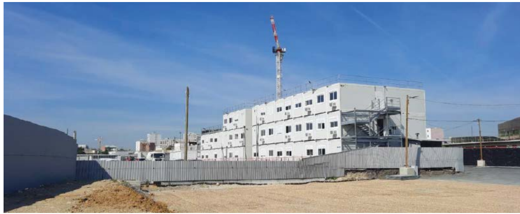
Bereits seit dem Aufbau des Athletendorfs sichert Sorhea die Baustellen
