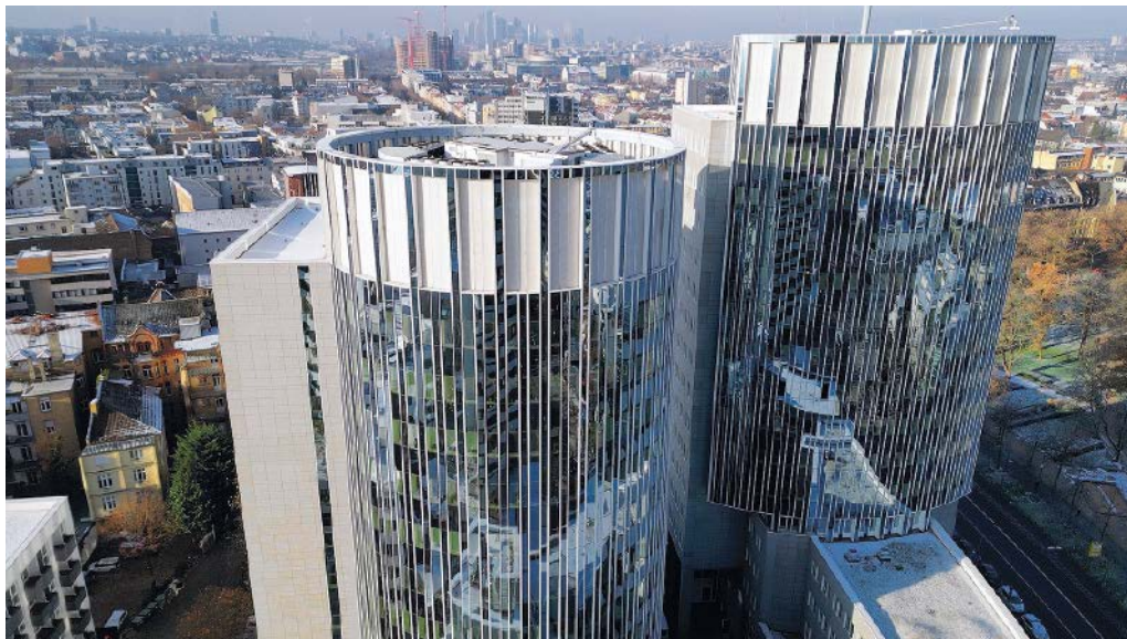
Winkhaus Zutrittsorganisation kontrolliert auch die Zugänge in das Haus der Wirtschaft, in dem viele Ämter der Stadt untergebracht sind
