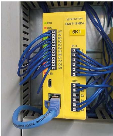
Mit dem programmierbaren Sicherheitsrelais SCR P bietet Bernstein ein Sicherheitsrelais speziell für die Auswertung der DCD Diagnosedaten, hier zu sehen im Schaltschrank eines Anwenders
