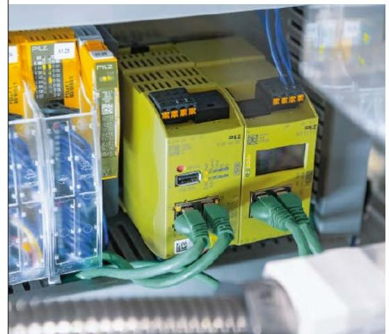
Die Industrie-Firewall SecurityBridge dient Steuerungen zum Schutz vor Angriffen und unautorisiertem Zugriff. Sie kontrolliert die Datenkommunikation innerhalb eines Automatisierungsnetzwerks
