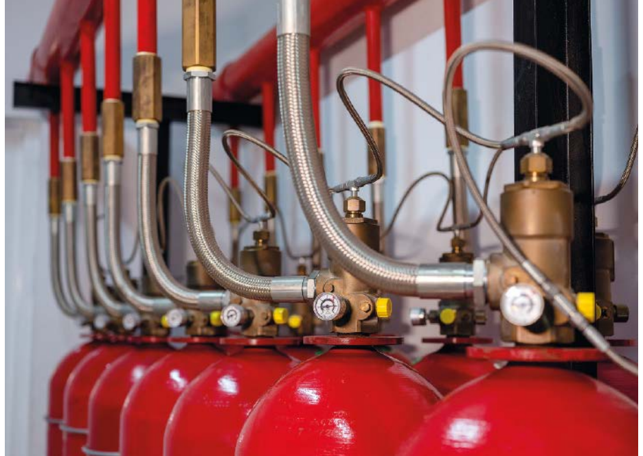
Gasförmige Löschmittel löschen auch verdeckte oder versteckte Brandquellen, indem sie den für den Brand notwendigen Sauerstoff verdrängen
