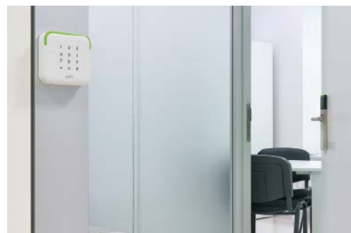
Für die Zutrittskontrolle empfehlen sich als Identifikationstechnologie RFID-Lösungen mit 13,56MHz wegen der höheren Sicherheit durch bessere Verschlüsselungsverfahren, der größeren Speicherkapazität und des schnelleren Datentransfers
