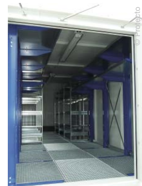
Der Protecto F-Safe Brandschutzcontainer F90/REI90 eignet sich für die Innen- und Außenaufstellung
