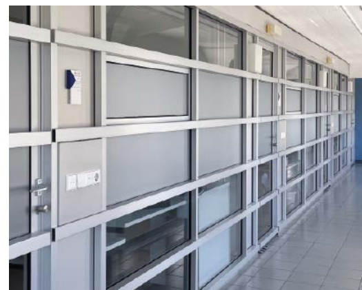
Derzeit sind 269 digitale Schließzylinder von SimonsVoss im Einsatz – überwiegend Doppelknauflzylinder 3061 – hier an den Eingängen zu den Büros
