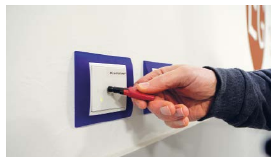
Offline Leser öffnen Rollstuhlfahrer die Türen automatisch, wenn sie ihren berechtigten Schlüssel identifiziert haben
