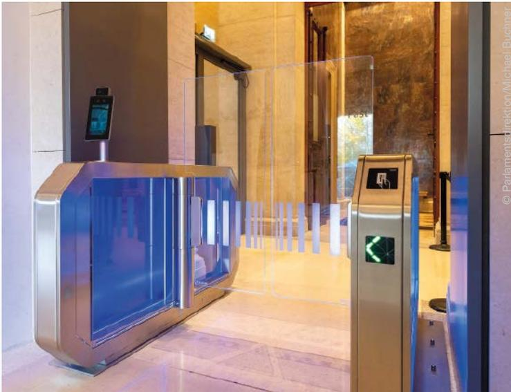
Zur Authentifizierung von Mitarbeitern wurde der Haupteingang des Parlamentsgebäudes mit einer Zutrittsschleuse von Wanzl ausgestattet. Das Galaxy Gate 1.1 hat eine Durchgangsbreite von 90 cm und ist auch barrierefrei für Rollstühle geeignet
