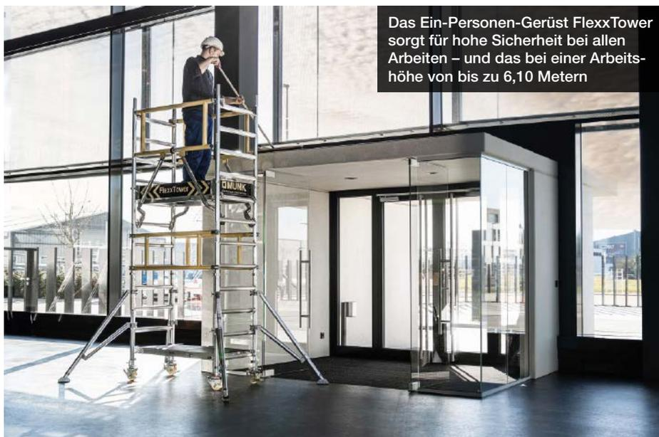
Das Ein-Personen-Gerüst FlexxTower sorgt für hohe Sicherheit bei allen Arbeiten – und das bei einer Arbeitshöhe von bis zu 6,10 Metern
