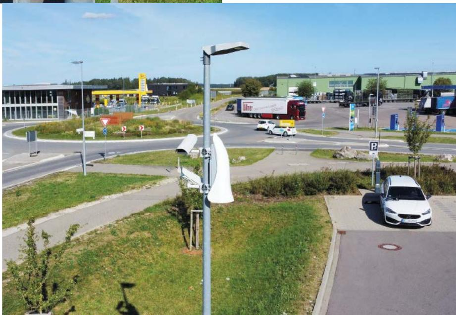
▲ **Rund-um-die-Uhr-Videoüberwachung kritischer Zonen dank EPV4. Angeschlossene Geräte: zwei Bullet Kameras, ein integrierter LTE-Überträger und ein Mini-PC**
