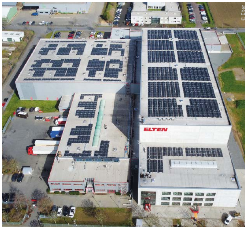
Um den Energiebedarf für den Herstellungsprozess von Sicherheitsschuhen zu decken, nutzt Elten den Eigenstrom seiner PV-Anlage
