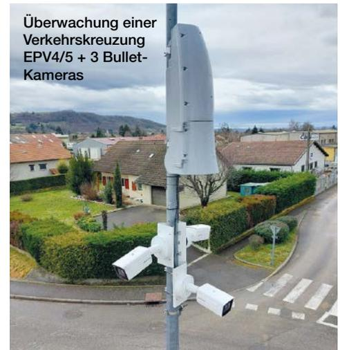
Überwachung einer Verkehrskreuzung EPV4/5 + 3 Bullet-Kameras
