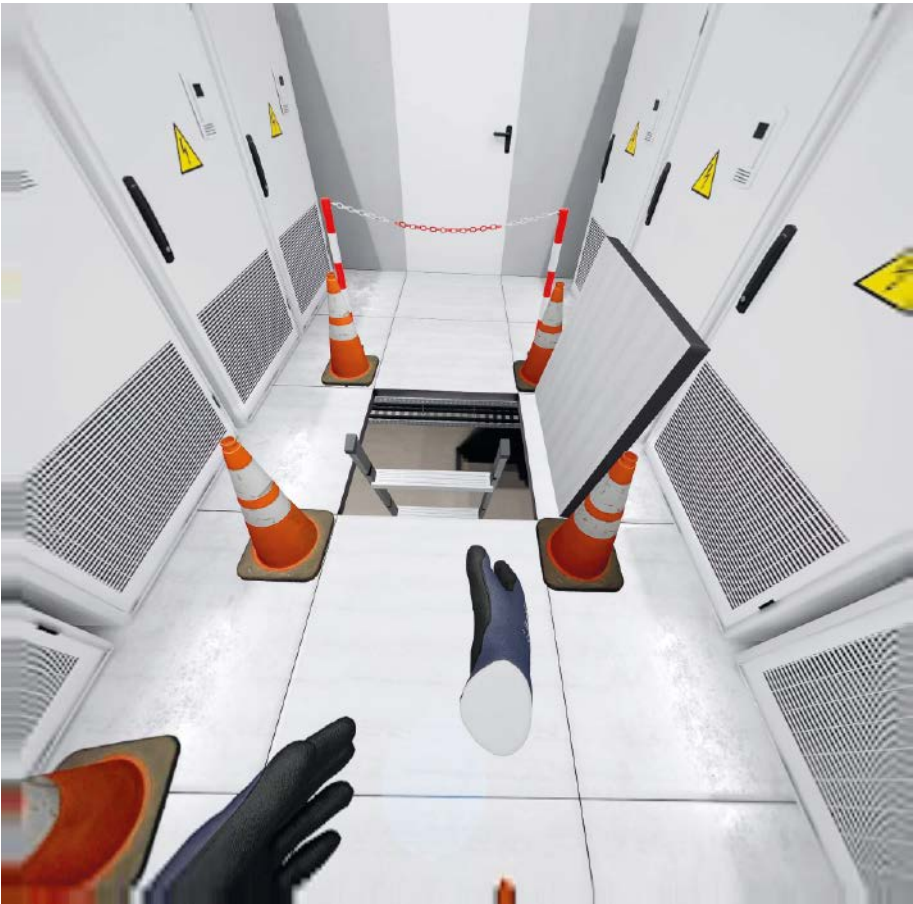
In diesem Szenario müssen die Trainingsteilnehmer einen offenen Zugang zum Doppelboden absichern, um anschließend sicher in den Doppelboden herabzusteigen und dort vorhandene Kabel abzuisolieren
