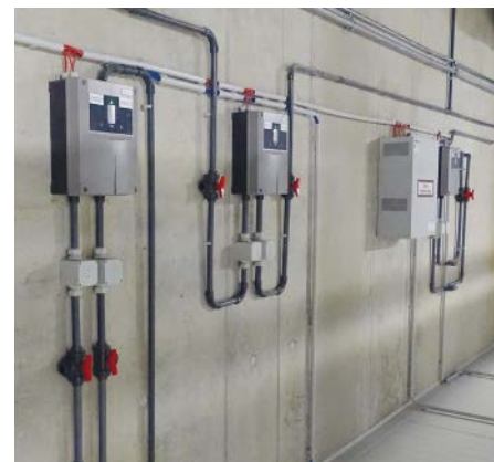
Ansaugrauchmelder saugen über eine Ansaugleitung (Rohrsystem) permanent Luft aus der Produktionshalle an und analysieren sie auf Rauchpartikel
