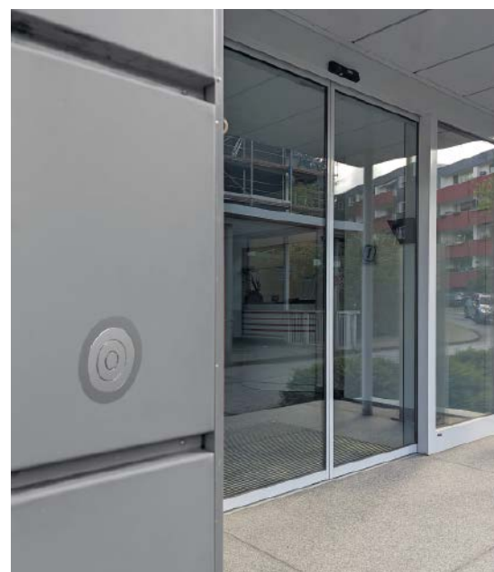
Rohrtresor in der Wand verbaut
