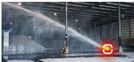
Die genaue Lokalisierung des potenziellen Brandherdes ermöglicht das automatische Einleiten weiterer Maßnahmen, wie zum Beispiel das Ablöschen durch einen Löschmonitor
