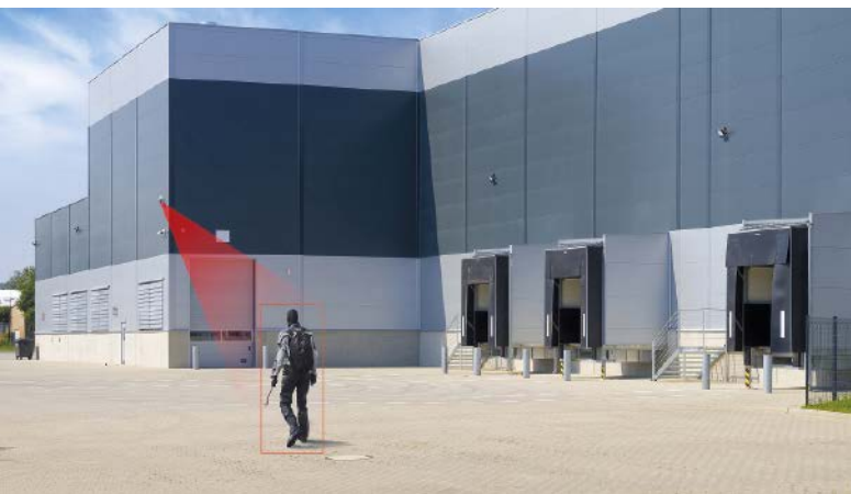
Mittels intelligenter Videosicherheitssysteme werden Eindringlinge zuverlässig erkannt und auf dem Areal über mehrere Kameras hinweg verfolgt
