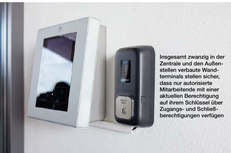
Insgesamt zwanzig in der Zentrale und den Außenstellen verbaute Wandterminals stellen sicher, dass nur autorisierte Mitarbeitende mit einer aktuellen Berechtigung auf ihrem Schlüssel über Zugangs- und Schließberechtigungen verfügen
