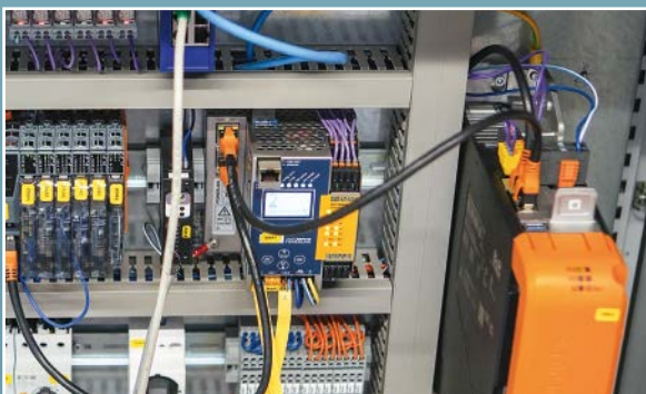
ASi-5/ASi-3 openSAFETY über POWERLINK Gateway BWU3865 von Bihl+Wiedemann mit integriertem Sicherheitsmonitor für zwei ASi Kreise.
