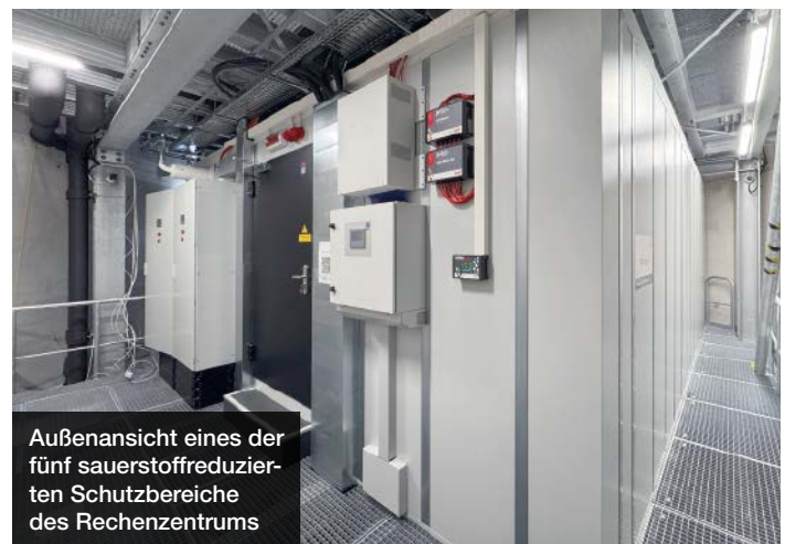
Die Wind Cores II: Wichmann Brandschutzsysteme sorgt mit einer N2ORS Brandvermeidungsanlage für den sicheren, nachhaltigen Betrieb
