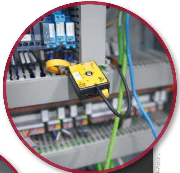
Aktiver Verteiler ASI Safety BWU3373 von Bihl+Wiedemann für die Integration von Sicherheitsschaltern in das ASI Netzwerk
