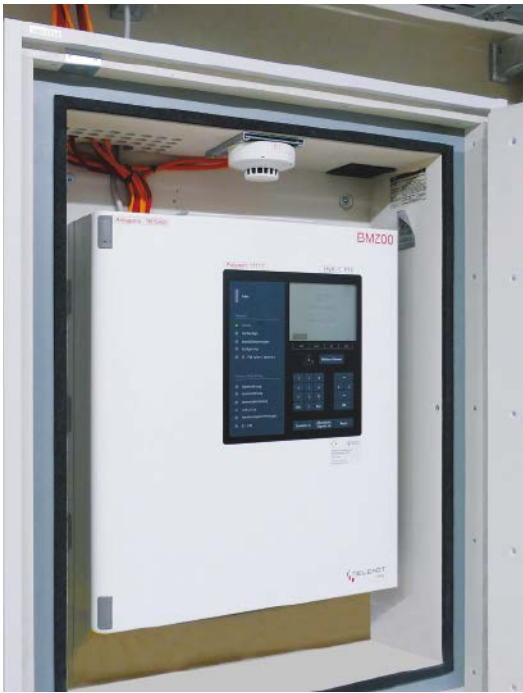
In der Telenot Brandmelderzentrale hifire 4400 im Keller laufen alle Fäden des Brandschutzsystems zusammen.
