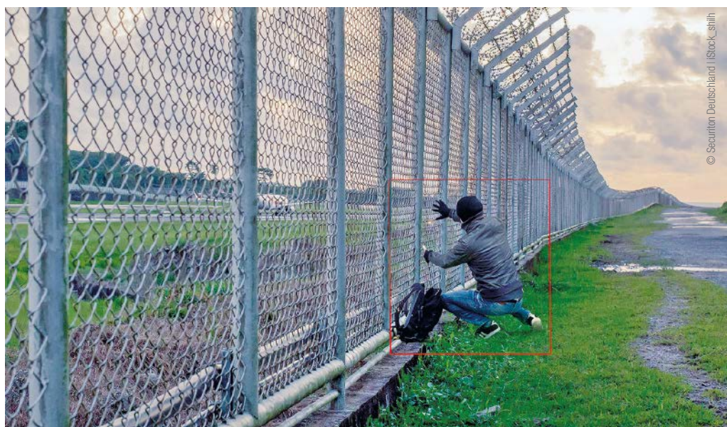
Perimeterschutz für ein Umspannwerk: Eine Absicherung nach dem Zwiebelschalenmodell ist daher das Mittel der Wahl
