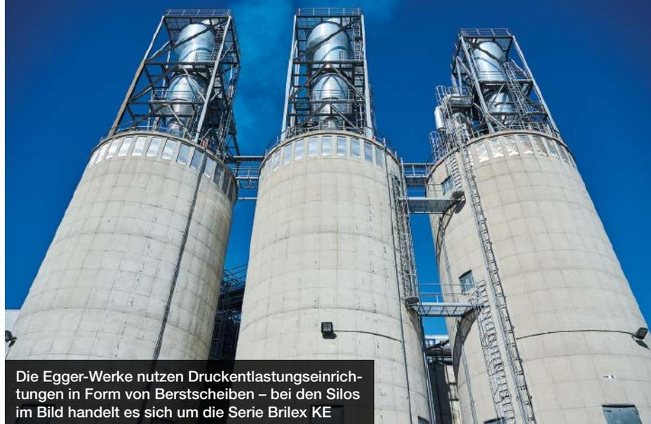
Die Egger-Werke nutzen Druckentlastungseinrichtungen in Form von Berstscheiben – bei den Silos im Bild handelt es sich um die Serie Brilex KE
