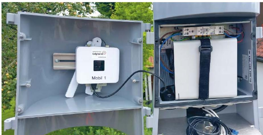
Geöffnetes EPV4-Anschlussgehäuse mit Managed Switch und Blitzschutz. Das LFP-Akku-System befindet sich im oberen Gehäuseteil. Zusätzlich verbaute Kundengeräte: Cloud Key, LTE-Router
