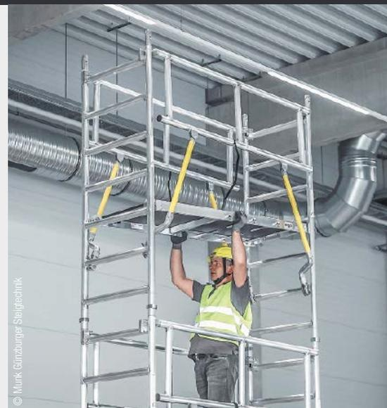
**Bis zu 40 Prozent Gewichtsersparnis bietet die neue Ergo-Plattform der Munk Günzburger Steigtechnik im Vergleich zu herkömmlichen Plattformen. Sie ermöglicht ein besonders ergonomisches Handling und effizienteres Arbeiten auf Rollgerüsten**
