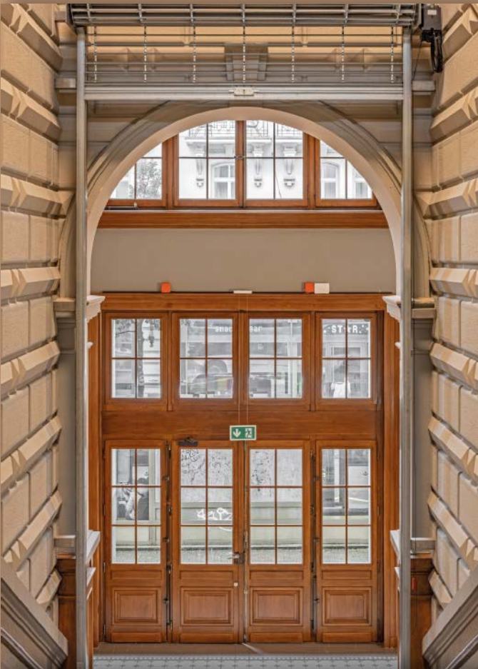
Zahlreiche Fenster wurden mit Fenstertechnik von Geze ausgestattet
