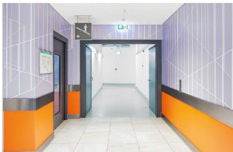
Im Brandfall sorgen automatisierte Rauch- und Wärmeabzugsanlagen dafür, dass Rauch effektiv abgeführt wird und Fluchtwege frei bleiben
